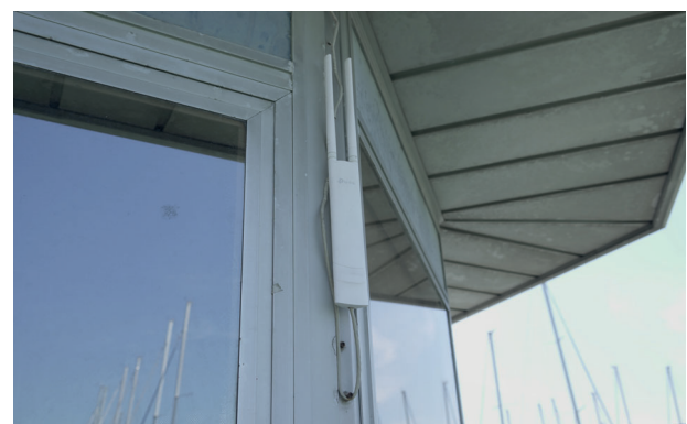
Access Point da esterno TP-Link EAP225-Outdoor
